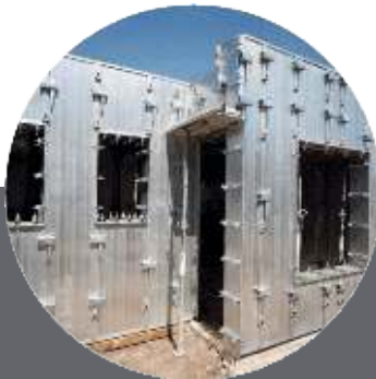
Montaje de encofrado STRONGFORMS para muros y losas
