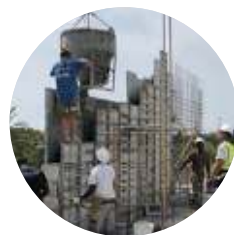
Vertido del hormigonado y vibrado
