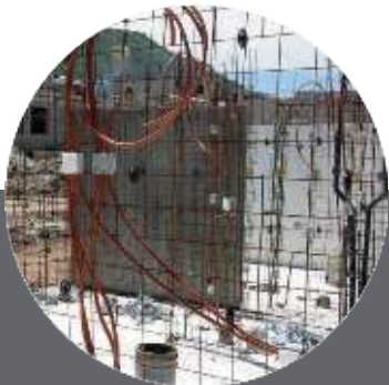
Colocación de acero de refuerzo, preinstalación de electricidad y fontanería
