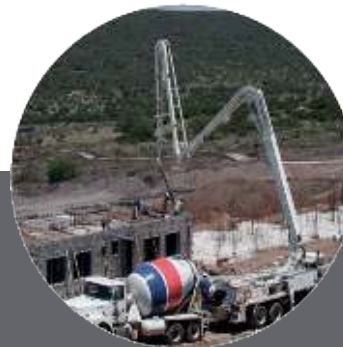
Vertido del hormigonado y vibrado
