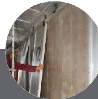
Desencofrado: de Paredes (10-12 horas)
