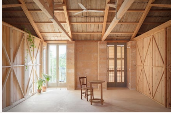
Imagen 7. Inercia, protecciones solares, aislamiento en cubierta de 24 cm de Posidonia oceanica seca y ventilador de techo en P1, 6 VPP en Santa Eugènia. Foto: Milena Villalba
