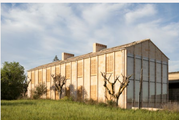
Imagen 8. Muro Trombe, protecciones solares y placas fotovoltaicas en 6 VPP en Santa Eugènia. Foto: Milena Villalba
