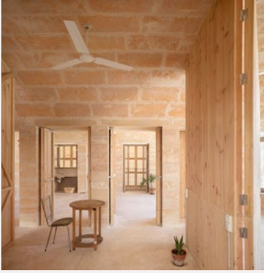
Imagen 6. Inercia, protecciones solares y ventilador de techo en PB, 6 VPP en Santa Eugènia. Foto: Milena Villalba
