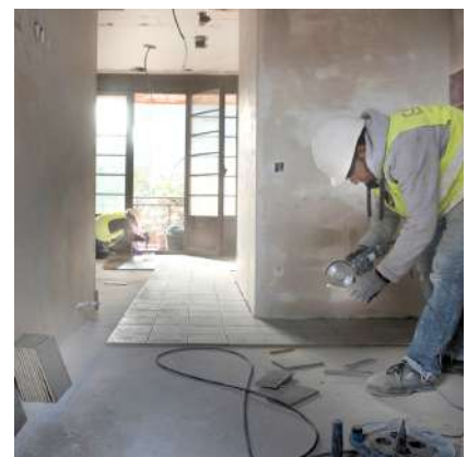
Rehabilitació d'habitatge social
