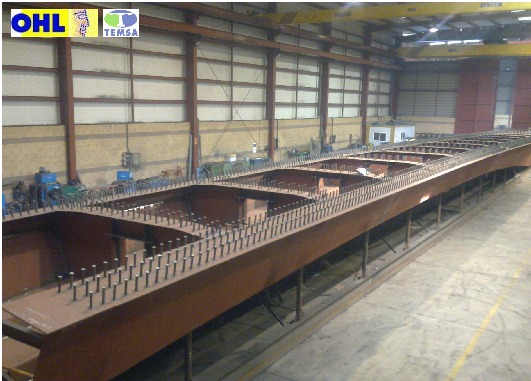
Puente Autovía Albolote Calicasar para OHL Tramo 1 long 39 mts.
