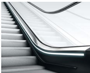
Iluminación de zócalo mediante banda continua LED
