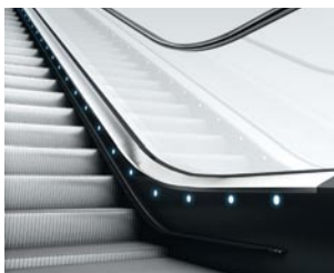
Iluminación de zócalo mediante spots
