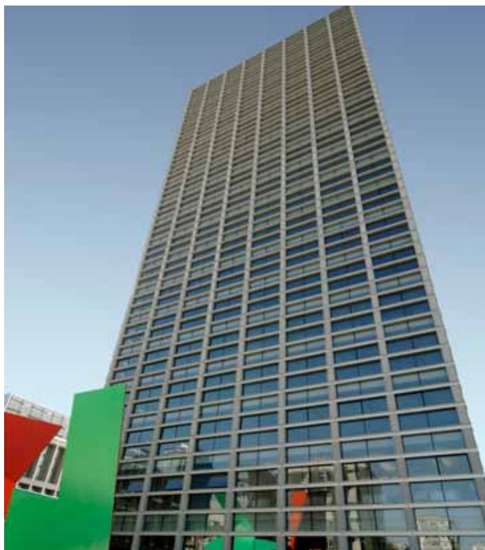
Edificio proyectado por Eduardo Souto de Moura en Oporto, Portugal.
