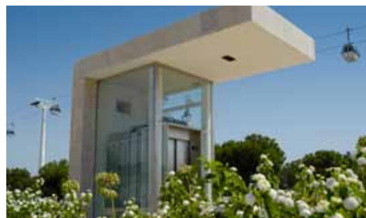
El respeto del medio ambiente es uno de los pilares fundamentales sobre los que se sustenta la filosofía empresarial de Enor.
