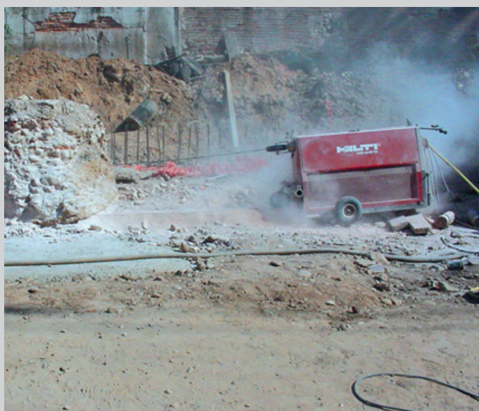
El hilo en seco puede ser usado en equipos de corte con hilo estándar, como la Hilti eléctrica DS-WS 15.
