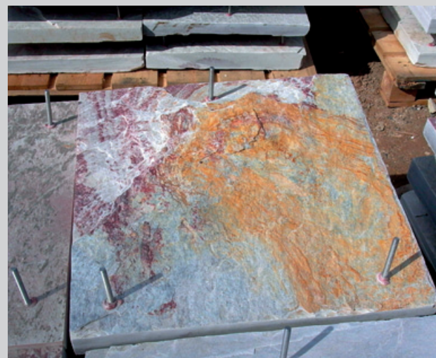
A las placas perforadas se les instalaban varillas roscadas con ayuda de anclaje químico Hilti HIT-RE 500.
