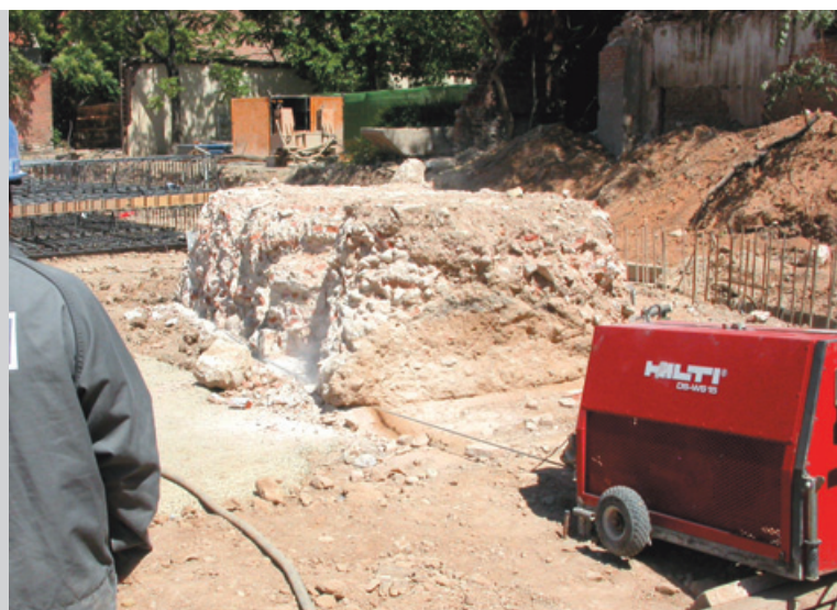
El equipo de corte con hilo eléctrico Hilti DS-WS 15 ejecutó el corte de forma rápida y eficaz.
