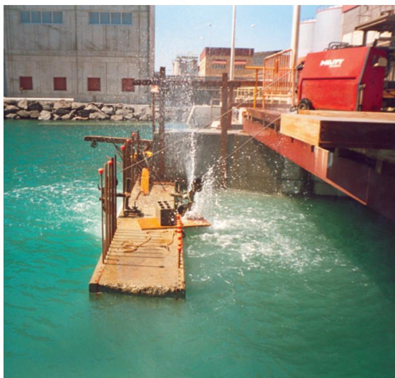
La DS-WS 15 de Hilti en pleno corte. Obsérvese la colocación de las poleas para crear un ángulo cerrado y aumentar la velocidad de corte.
