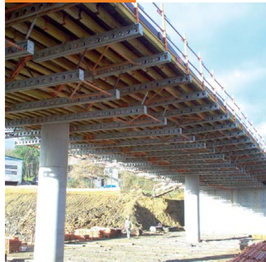
encofrado de tablero para puentes Cliente: FCC Encofrado de tablero en ala de gaviota realizado mediante vigas Superslim y vigas de madera de RMD Kwikform para la ejecución de varios pasos superiores en la Autovía del Cantábrico, España.
