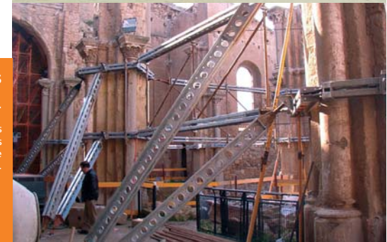
apeo de pilares Cliente: UTE Teatro Romano. Se utilizaron vigas y correas Superslim para el apeo de los pilares del Teatro Romano de Cartagena, España.
