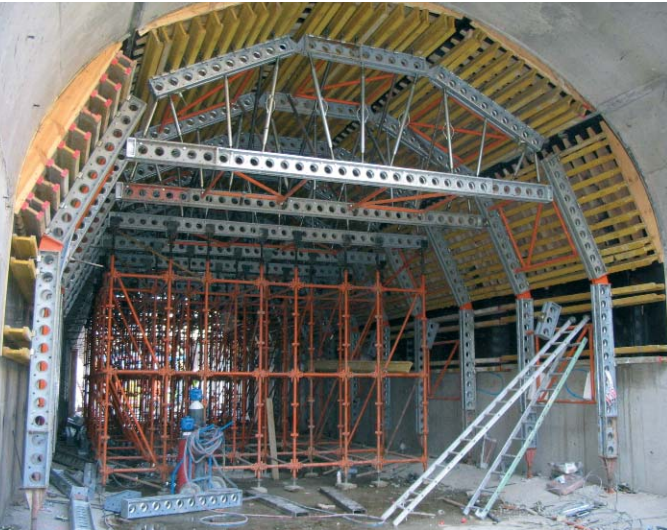
encofrado para túnel Cliente: Ferrovial Agroman. Se utilizaron vigas Superslim con tensores y camones de madera para la ejecución del encofrado de bóveda de un falso túnel de 165ml para la ampliación de la línea 5 del Metro de Madrid, España.
