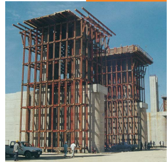
apuntalamiento vertical Cliente: Bilfinger, Bergen Ch. Karnchang, Tokio Explotando al máximo la gama de accesorios, se ha utilizado el sistema Slimshor para satisfacer los requisitos de soporte del cliente para construir el ferrocarril Bang Pan In Pakret, Bangkok.
