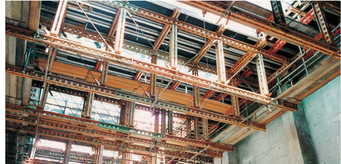
vigas y celosías para grandes vanos Cliente: MacMahon (WA) Pty. Ltd. Vigas Superslim de RMD Kwikform ensambladas en celosía para soportar las cargas de un vano en la construcción de losas de hormigón del proyecto hidráulico del Río Ord, Australia.
