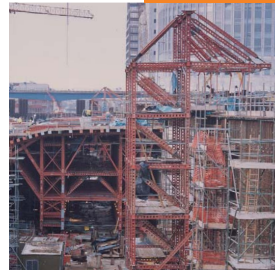
pórticos móviles Cliente: UTE Tarmac Bachy. Las vigas Superslim de RMD Kwikform utilizadas para montar el pórtico móvil en voladizo soportan los paneles de encofrado de muro de doble cara de 11,5 m de altura x 20 m de longitud en el perímetro de la estación de metro de Canary Wharf, Jubilee Line, Londres, Reino Unido.
