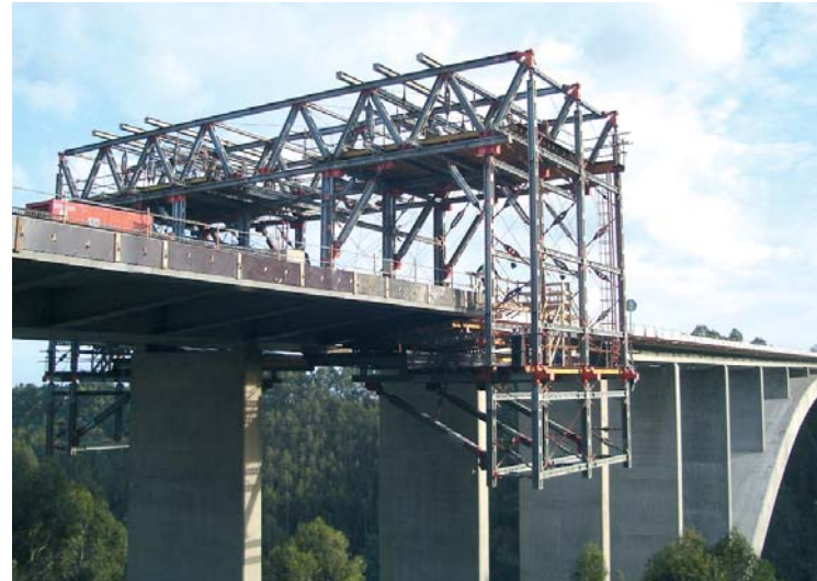
carro de hormigonado de alas Cliente: UTE Ballota (Aldesa - Tableros y Puentes) Para el ensanchamiento del tablero del viaducto Pintor Fierros en Asturias, España, con mantenimiento del tráfico, se utilizó un carro constituido por vigas Superslim entre otros materiales estándar de RMD Kwikform.
