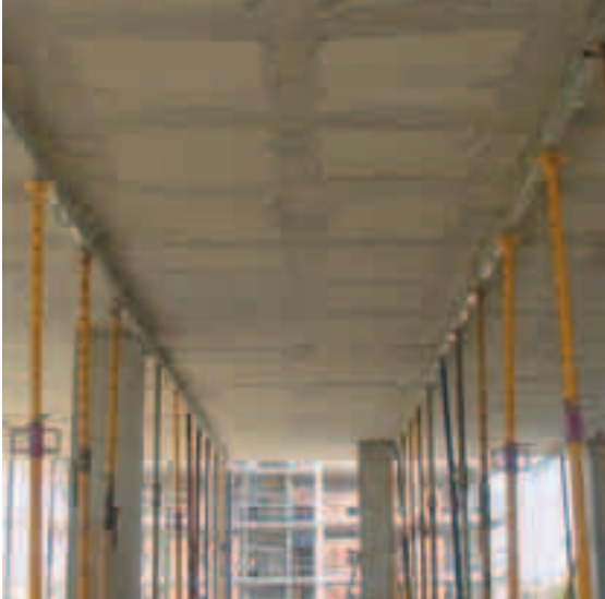
Sopandeo de forjado de plano aligerado.
