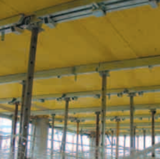
Planta encofrada para forjado plano.
