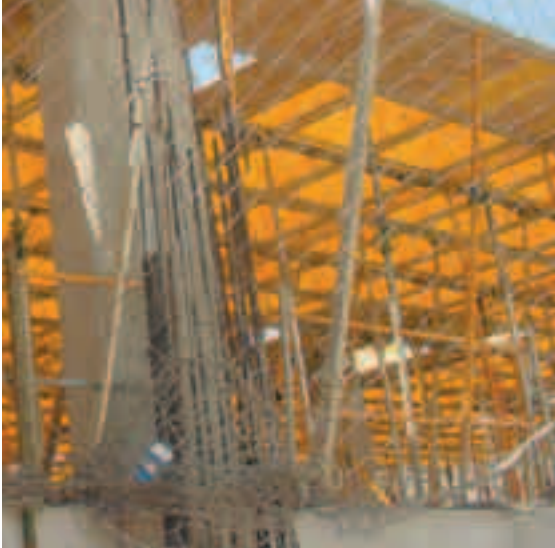
Planta encofrada para forjado de cubetas.
