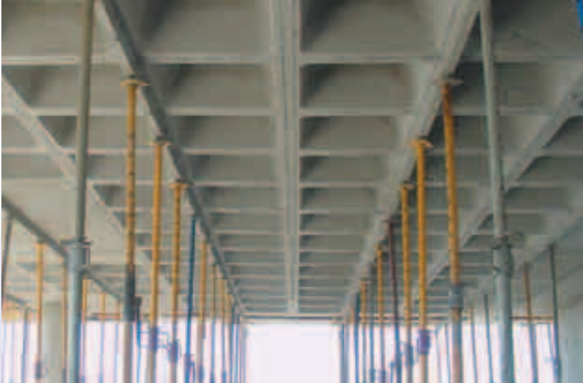
Sopandeo de forjado de cubetas.
