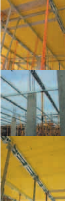
Slimdek en obra.
