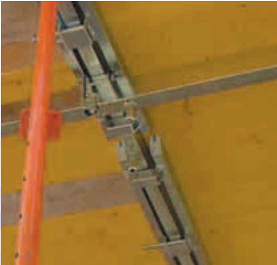
Detalle de Slimdek en obra.
