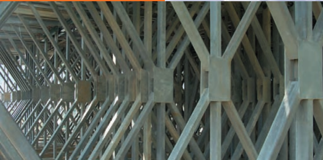
Los paneles superior e inferior de dos construcciones de dos pisos están conectados entre sí usando 4 pernos de cordón R584/panel
