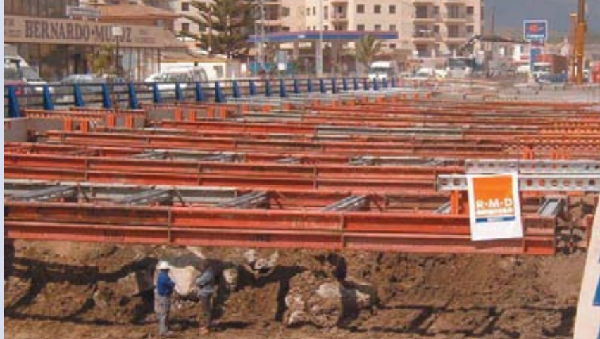
Cliente: Ferrovia Proyecto: Apuntalamiento en Autopista Estepona Gaudiaro, Málaga
