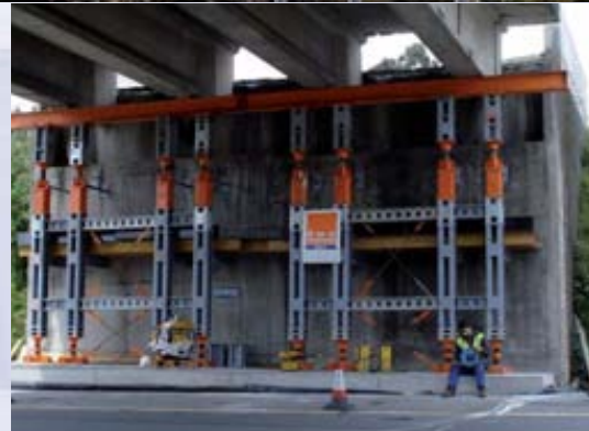
Cliente: GAOS Contratas y Construcciones Proyecto: Elevación de paso superior, Piadela, La Coruña
