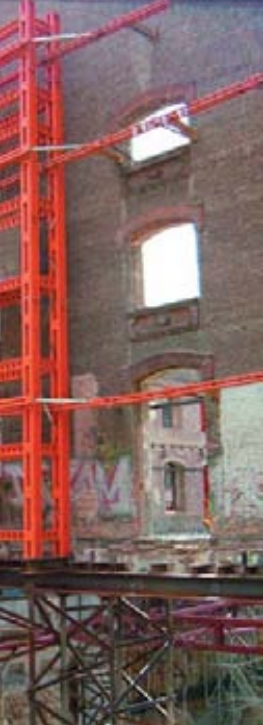
Cliente: Ferrovial Proyecto: Estabilización de fachada, Sede Fundación La Caixa, Madrid
