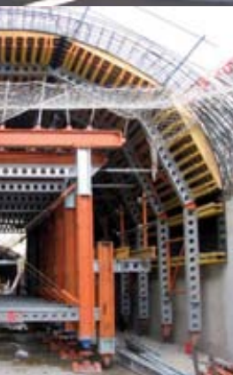
Cliente: Ferrovial Proyecto: Falso Túnel, Línea 5 de Metro, Madrid
