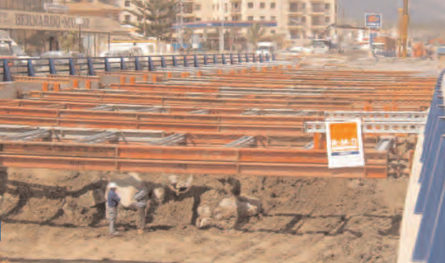
Autopista de Estepona - Guadiaro en Málaga. FERROVIAL AGROMAN.
