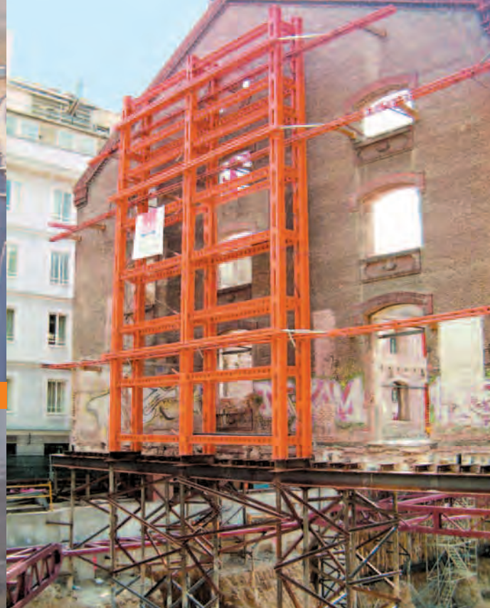
Edificio Caixa - Forum en Madrid. FERROVIAL AGROMAN.
