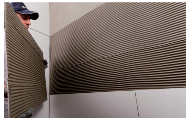
Posa della lastra sottile a parete
