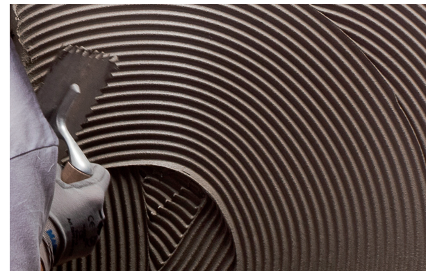
Applicazione di Ultralite S2 su intonaco
