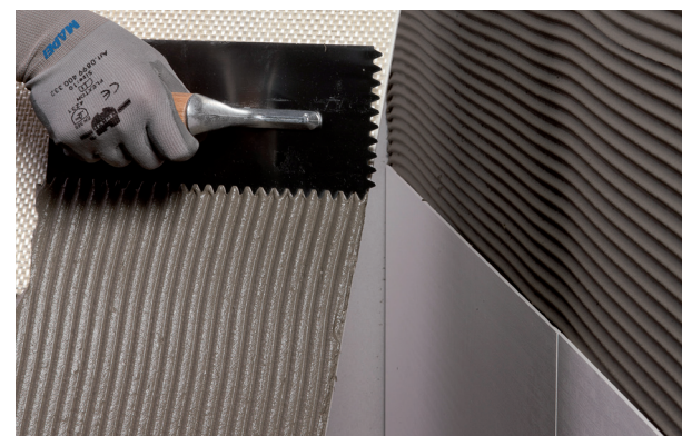
Applicazione di Ultralite S2 sul retro della piastrella
