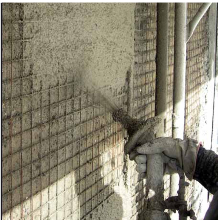
foto 8 Applicazione a spruzzo di Mapegrout BM
