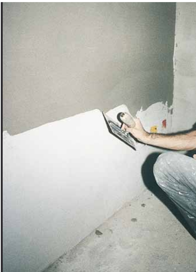
foto 15 Rasatura con Planitop 100
