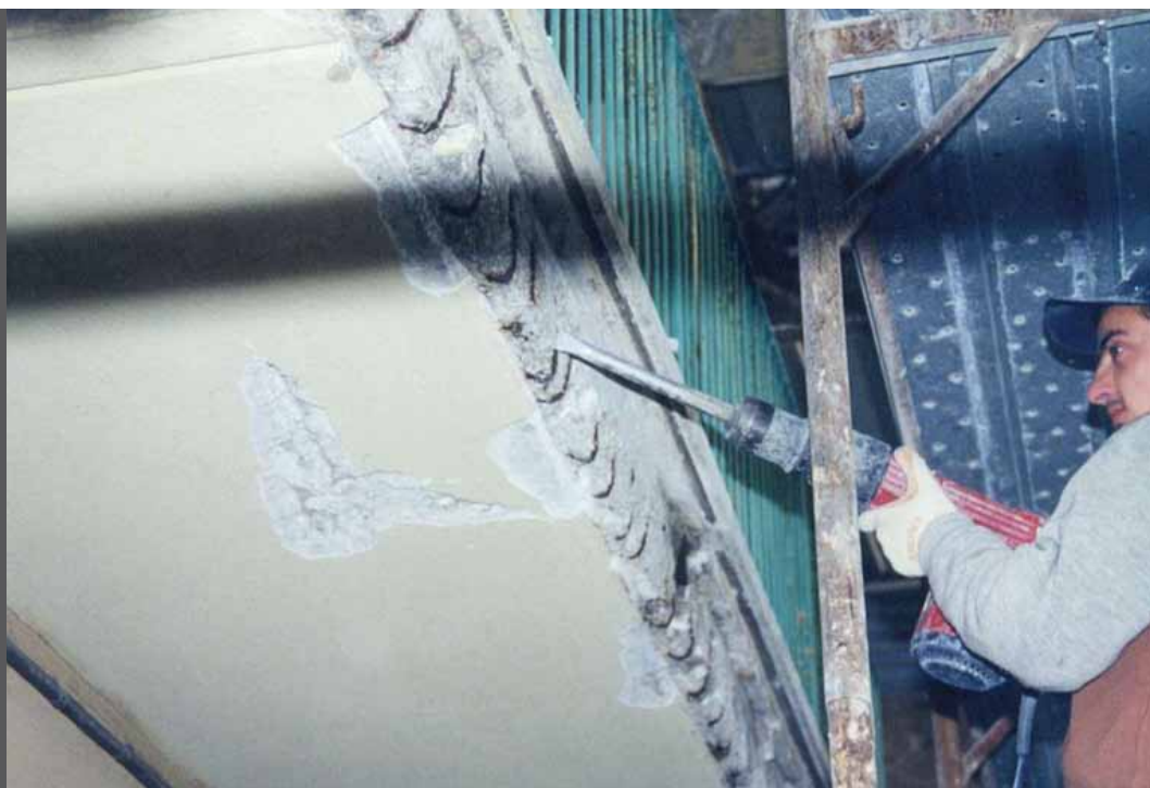
foto 1 Demolizione meccanica di un frontalino di balcone.
