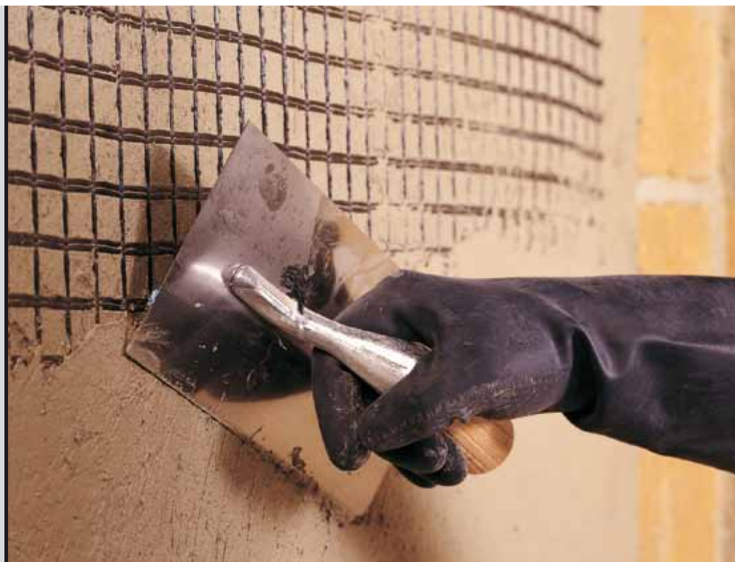
foto 26 Rasatura armata con Planitop HDM
