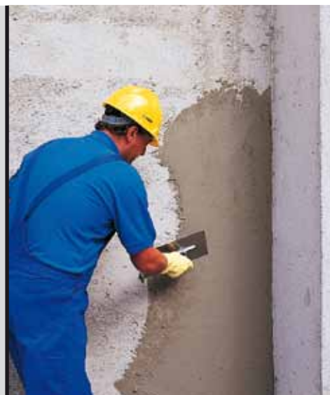
foto 20 Rasatura con Monofinish
