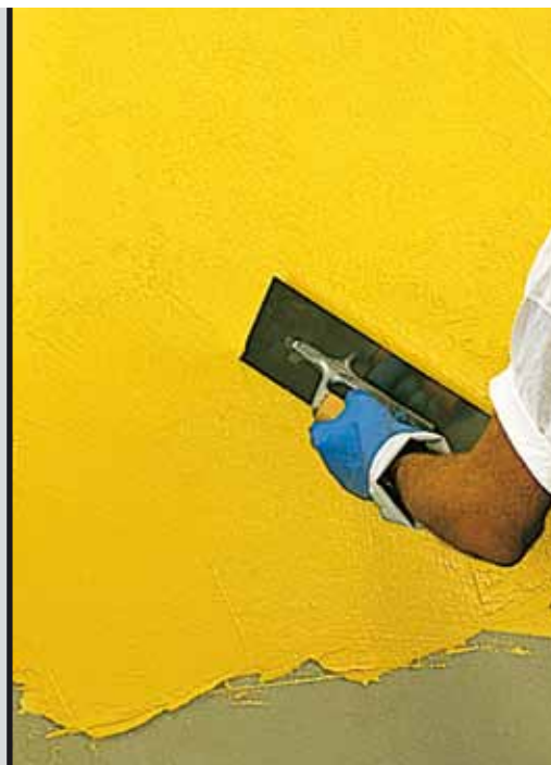
foto 33 Applicazione di Silancolor Tonachino
