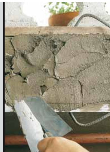
foto 9 Applicazione di Mapegrout Rapido
