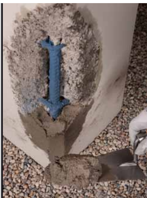
foto 11 Applicazione di Mapegrout LM2K
