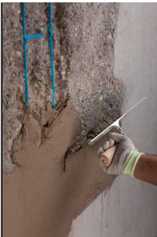
foto 6 Applicazione di Planitop Rasa & Ripara
