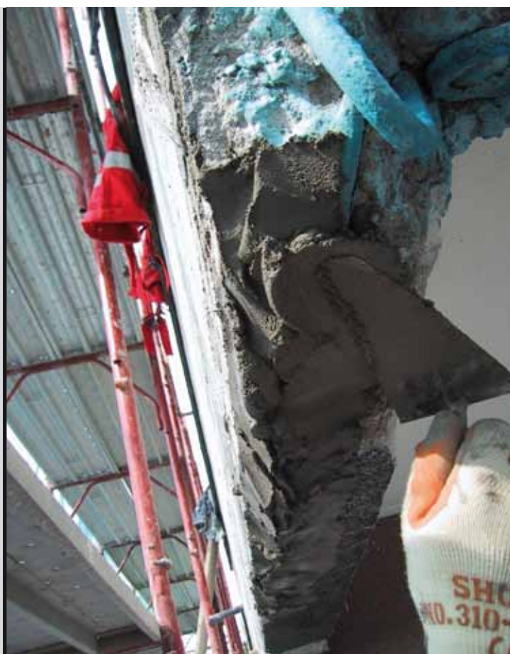
foto 7 Applicazione di Mapegrout T60
