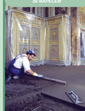
Regleado del recrecido de MAPECEM
