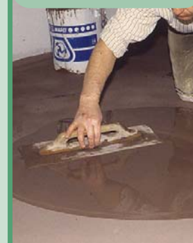
Nivelación realizada con ULTRAPLAN MAXI
