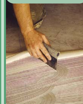
Aplicación del adhesivo con ADESILEX V4
