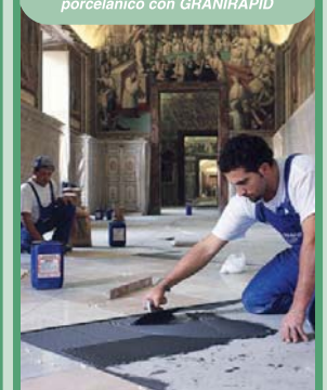
Colocación de baldosas de gres porcelánico con GRANIRAPID
