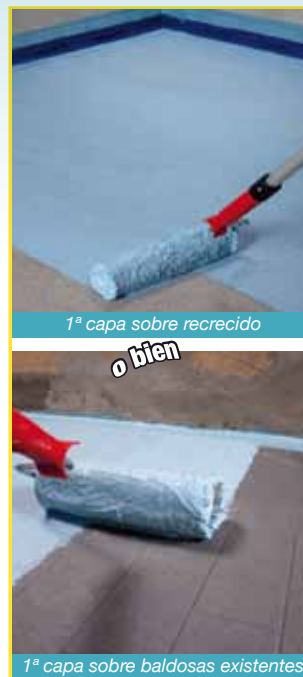
1ª capa sobre baldosas existentes
