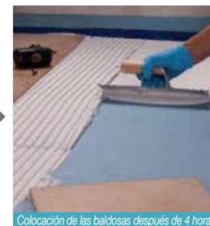
Colocación de las baldosas después de 4 horas
