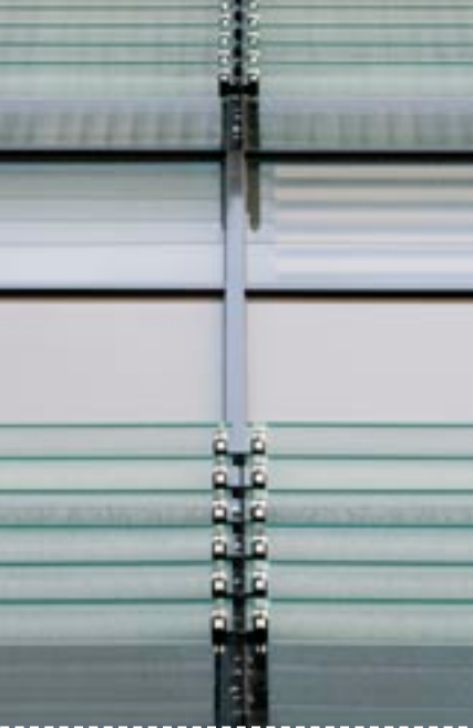
Fragmento del muro cortina del edificio alto
