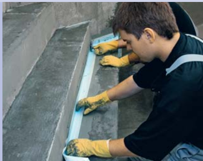
Colocación de PCI Pectape® 120 sobre PCI Seccoral® 1K o Masterseal® 550 fresco.
