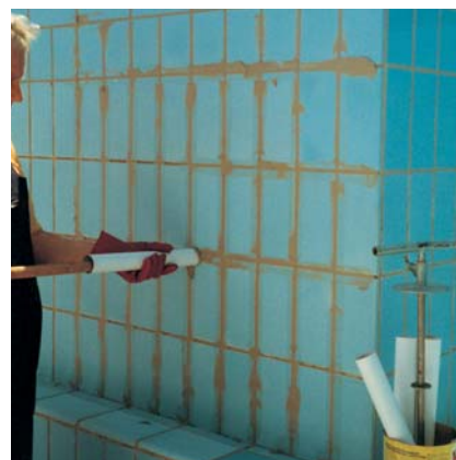
Las viejas juntas cementosas dañadas se pueden reparar con PCI Pericolor® Flex plus.o PCI Pericolor® Epoxy
