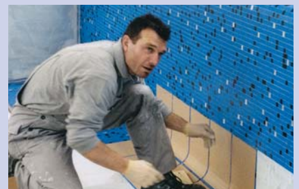
... las baldosas se adhieren con seguridad sobre el acero y poliéster.
