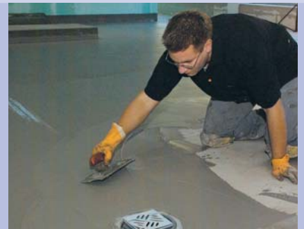
Aplicación de la pasta impermeable especial PCI Seccoral® 1K o Masterseal® 550.
