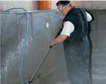
Preparación del sustrato de hormigón utilizando una lavadora de alta presión o arenado.
