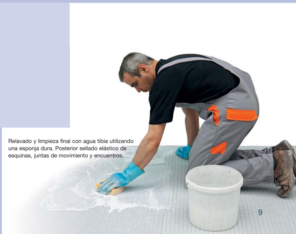
Rejuntado de paredes y suelos utilizando un sistema de resina de reacción de gran resistencia PCI Pericolor® Epoxy.
