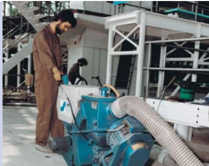
Soporte libre de polvo, pre-tratamiento del suelo utilizando granallado.
