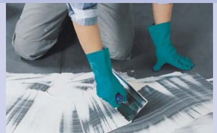
Usando el adhesivo especial y flexible de baldosas PCI Pericol® PU Flex...
