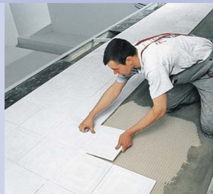
Colocando una baldosa cerámica de tamaño grande usando PCI Nanolight®.
