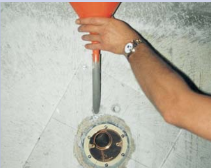
Sellado de tubo pasante con inyección impermeable de Concrese® 1360 o Masterflow® 140.
