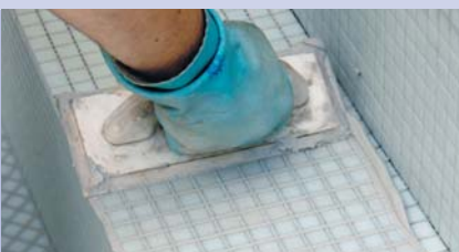
Rejuntado de paredes y suelos utilizando un sistema de resina de reacción de gran resistencia PCI Pericolor® Epoxy.
