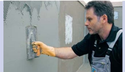
Nivelación de soporte desigual (paredes):
