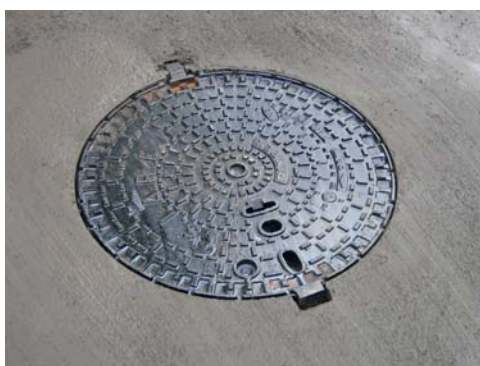
Emaco® Fast Fluid para reparar y nivelar cercos de alcantarillado- Francia.
