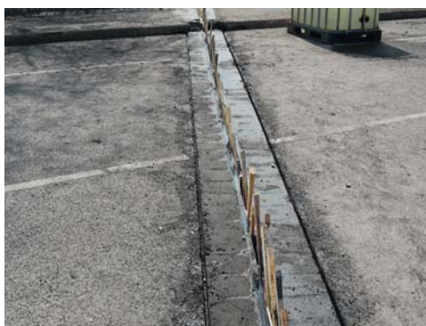
Emaco® Fast Fibre en reparación de junta de calzada - Países Bajos.
