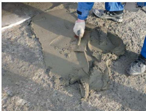
Reparación puntual con Emaco® Fast Tixo en pendientes.
