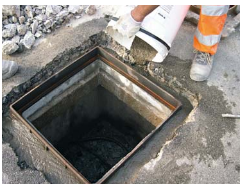
Emaco® Fast Fibre aplicado para reparación de grandes superficies y como nivelación para tapas de registro - Italia.
