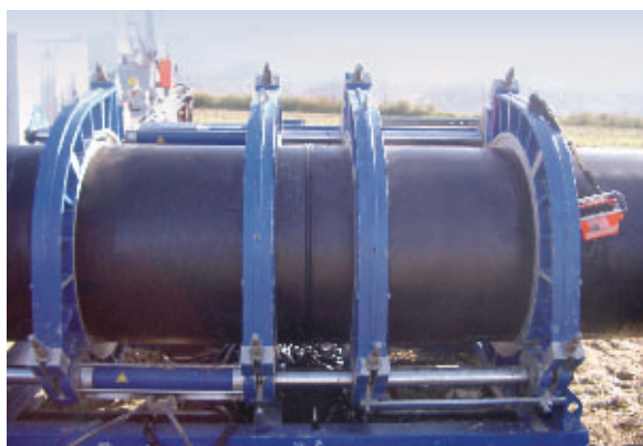
Obra Aeropuerto de Barcelona PE100 ø630 600 MT
