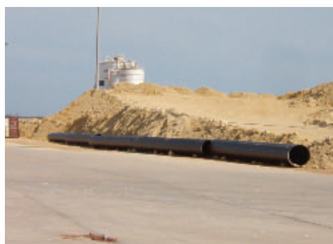
Desaladora de Melilla, PE80 ø1000 500 MT
