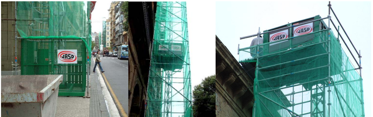
Montacargas para obra / Material Hoist Rehabilitación / Rehabilitation
