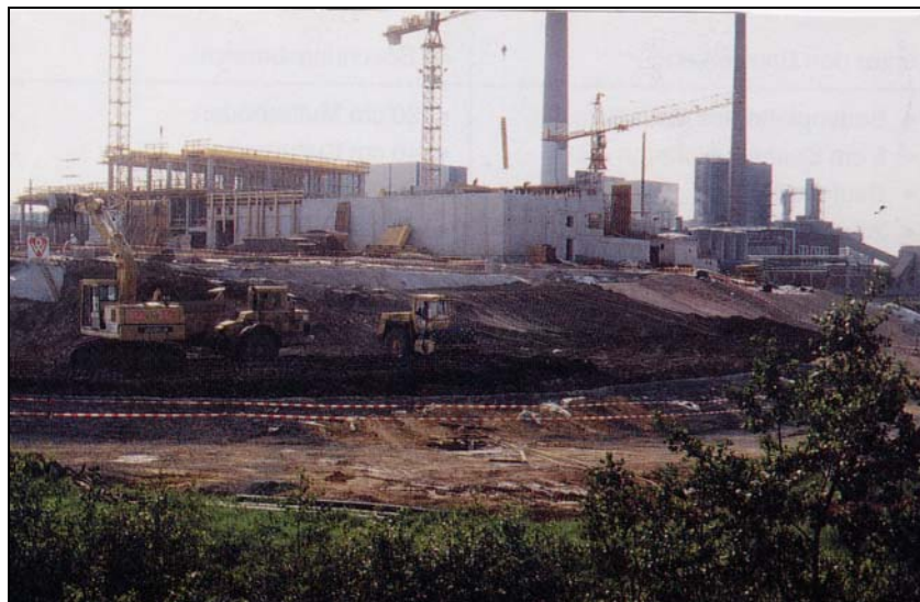
Área del vertedero con las obras de la depuradora en construcción y, al fondo, la papelera
