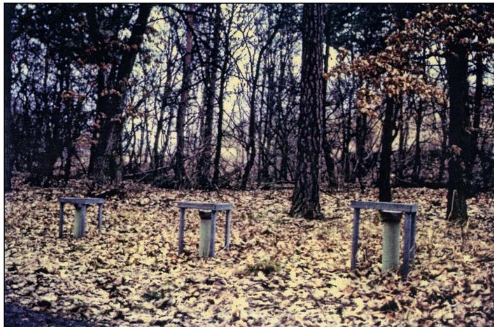
Fig. 4 Pozos para el control y seguimiento de aguas subterráneas
