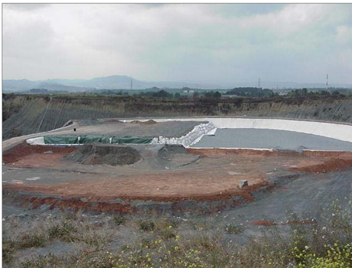
Vertedero Castellolí. Disposición de cenizas compactadas – El proceso KOMPACTAT ®
