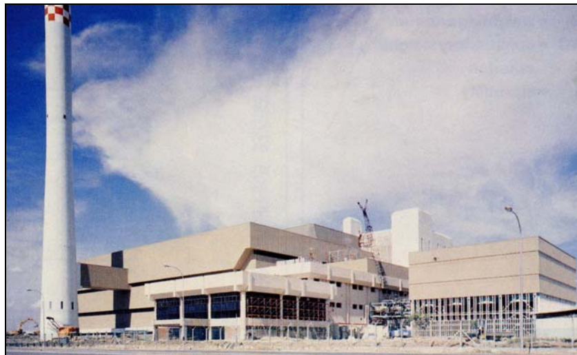
Fig. 5 Planta Incineradora de residuos domésticos e industriales en Singapur: tiene una capacidad de 2.000 t/día y genera una potencia eléctrica de 38 MW
