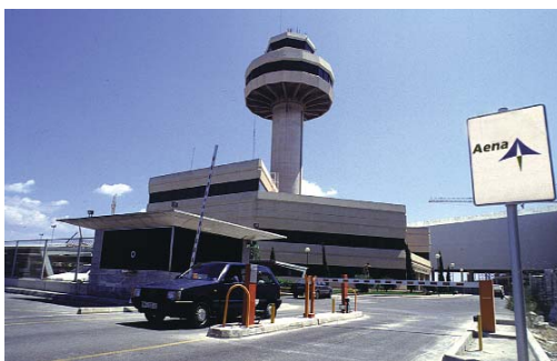
Aparcamiento de aeropuerto equipado con SCAVE .
