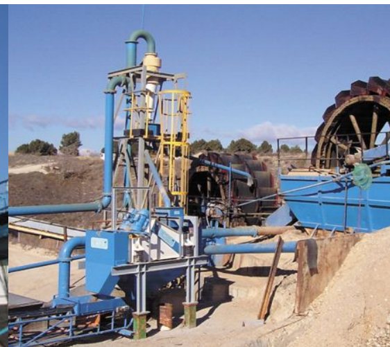
Recuperación de arenas finas
