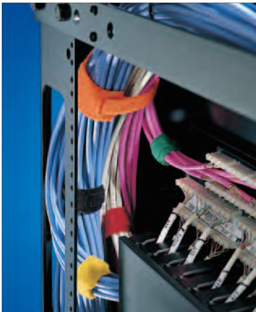
Dado a su variedad de colores las "Bridas Textiles", dan a los cables una identificación rápida y simple.
