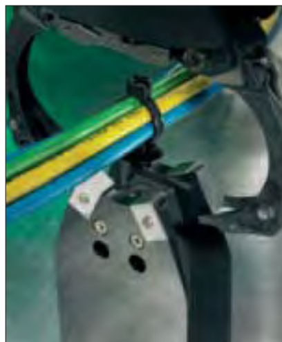
... quedando totalmente posicionada y atada al cableado.
