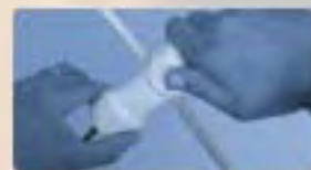
10. Apretar firmemente la tapa en el cable creando, de esta manera, el contacto eléctrico. Tighten with strength the cap to the cable, so creating the electric contact.
