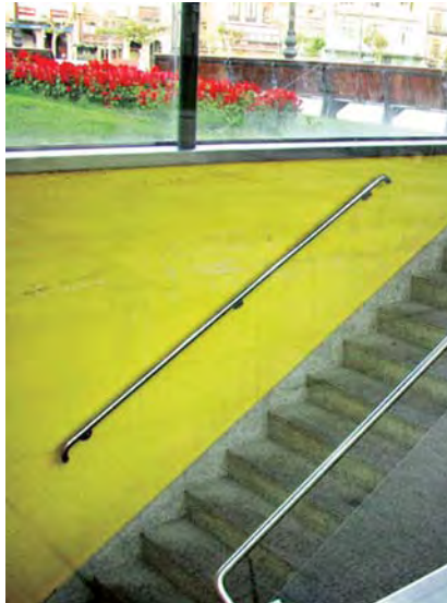
OBRA: Parking subterráneo Manresa Año 2002
