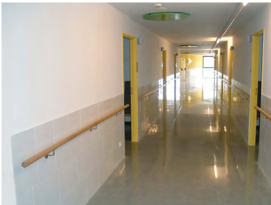
OBRA: Geriátrico de Cornellá Año 2004
