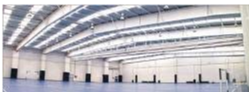
Vista interior con translucidos de cubierta
