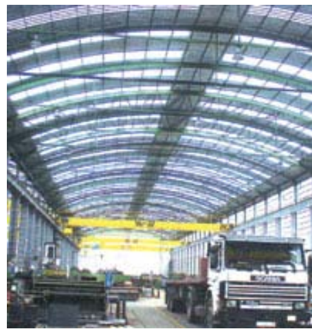
VISTA INTERIOR DE CUBIERTA CURVA
