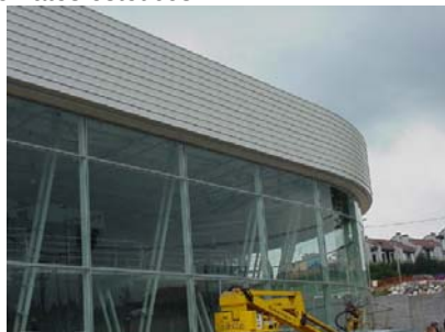
Aplicación de placa curvada en fachada
