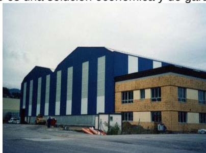
Vista exterior de fachada con translúcido
