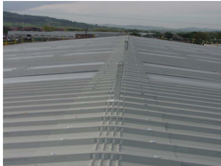
REMATE DE CUMBRERA MEDIANTE PLACA CURVADA HA-40/250
