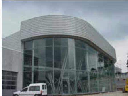
MONTAJE DE FACHADA HORIZONTAL CON PLACA HA-30/265
