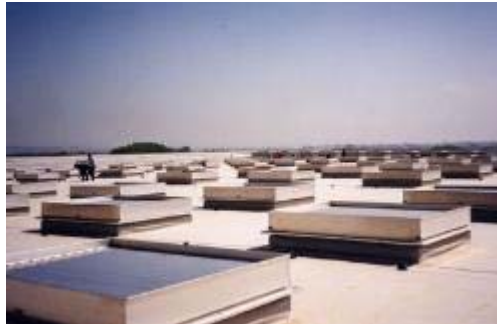
Salidas en cubierta
