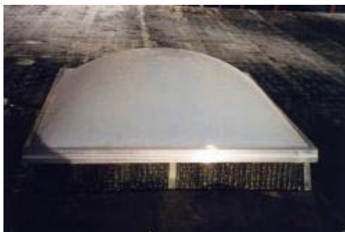
Lucernario (claraboya) en cubierta
