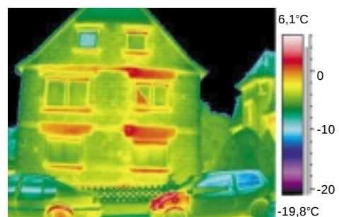
Puntos calientes debidos a fallos en el aislamiento
