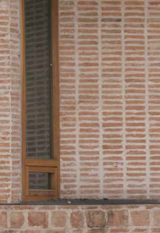
ladrillo manual blanco de 40 24 x 11 x 40 mm. 2 kg. 600 uds./palet
