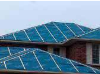
Lámina bajo teja, impermeable y transpirable
