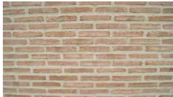
ladrillo manual blanco de 40 24 x 11 x 40 mm. 2 kg. 600 uds./palet
