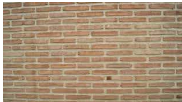
ladrillo manual cuero de 40 24 x 11 x 40 mm. 2 kg. 600 uds./palet
