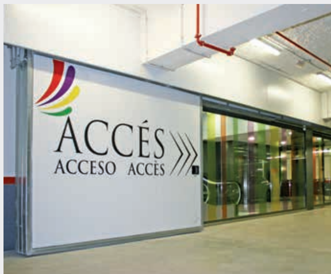
Puerta corredera cortafuegos en centro comercial.
