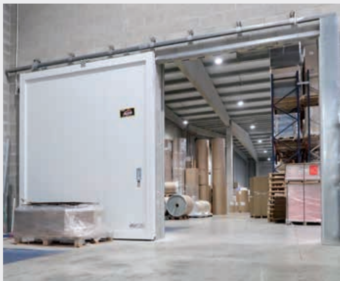
Puerta corredera cortafuegos en industria papelera.
