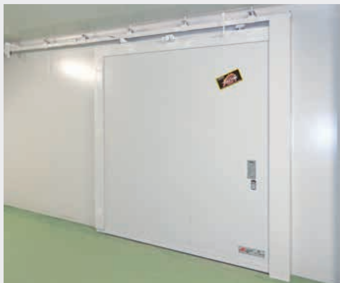
Puerta corredera cortafuegos en industria textil.
