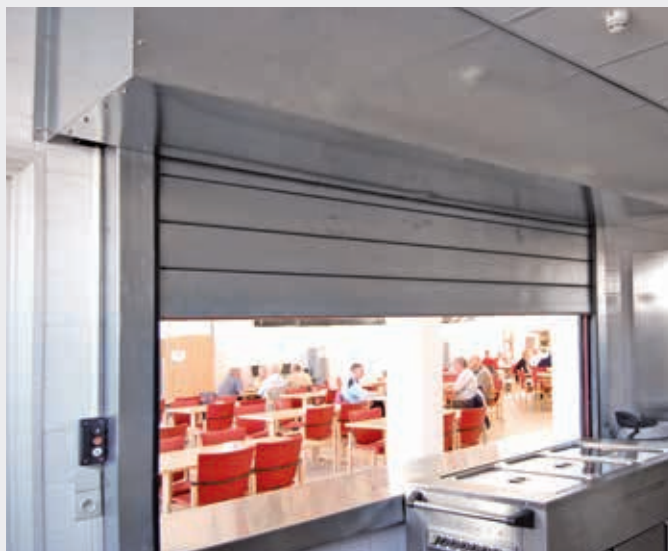
Puerta cortafuegos EI-Roll Premium® en cocina industrial.
