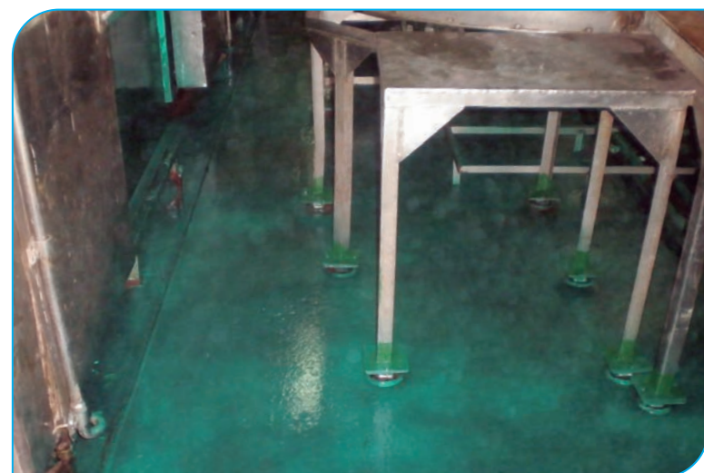
Revestimiento poliuretano en suelo de parque de pesca.
