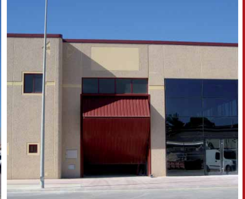
Polígono Industrial La Estación. Alcañiz (Teruel)
