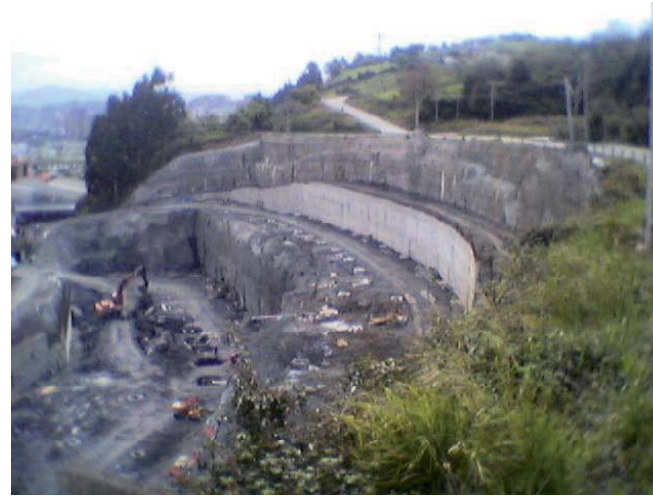
Desmonte del Terreno
