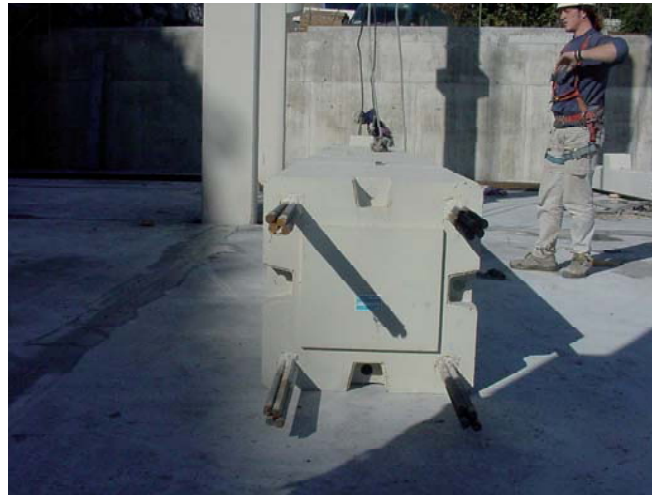
Detalle de Montaje de Pilar envainado
