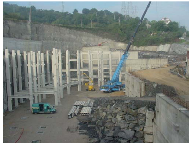
Montaje de la Estructura (pilares envainados)
