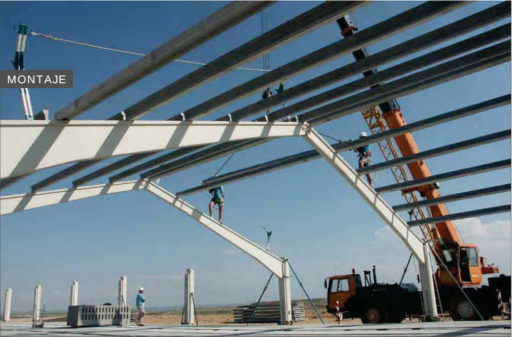
Montaje de Viguetas de Cubierta por parte de Montadores de la Empresa, utilizando nuestro Sistema de Seguridad Patentado: Sistema Ariadna
