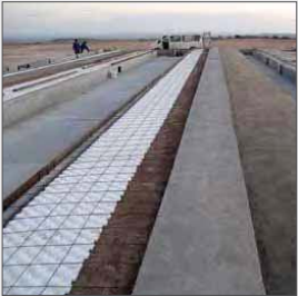
4 | Sistema de Calefacción.
