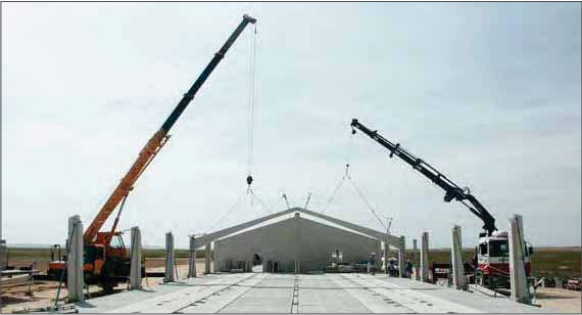
Montaje de Dinteles del Sistema Pórtico
