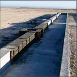
2 | Cimentación de Muros.
