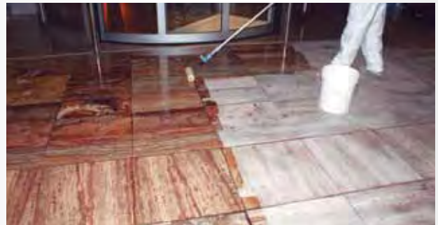
Aplicación de la imprimación / sellador de rápido curado
