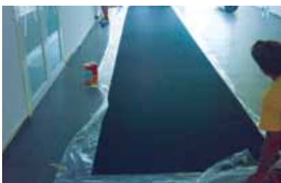
Preparación previa de mat de caucho
