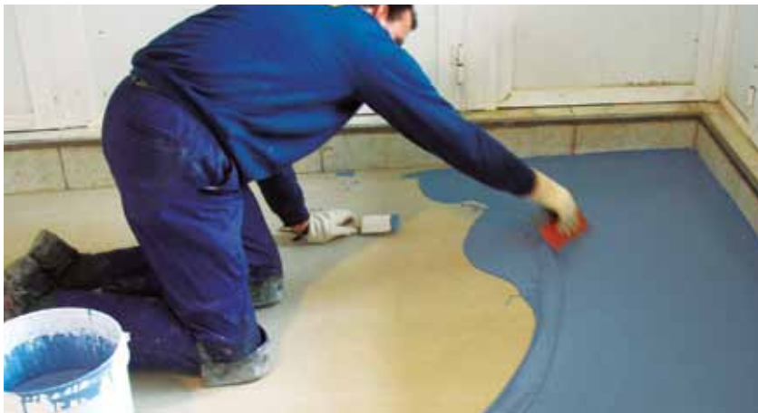
Aplicación de la capa base
