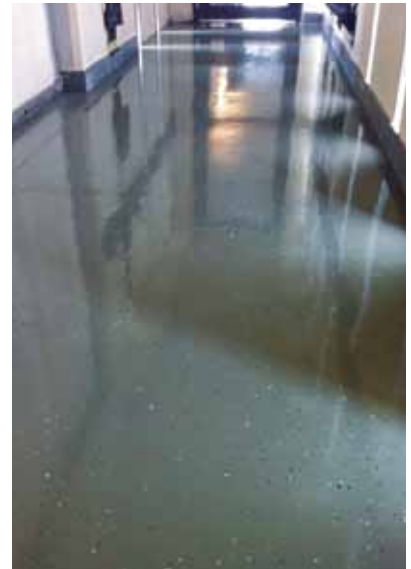
Pasillo en edificio institucional
