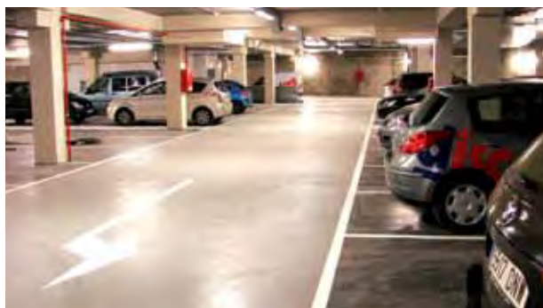
Parking centro comercial Mataró
