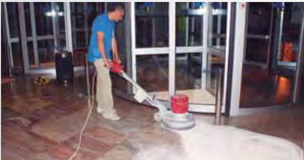
Lijado del pavimento con una máquina de disco, de cara a abrir el poro en el pavimento y mejorar el agarre posterior del sistema. Después aspirar el polvo en profundidad.
