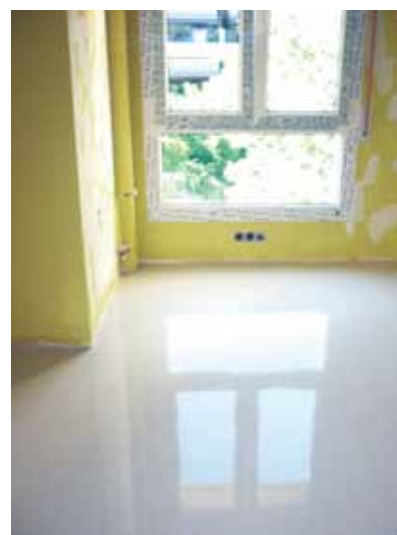
Rehabilitación de una habitación
