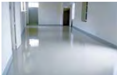
Zona común en vestíbulo
