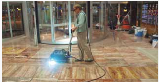
Curado de la resina mediante la máquina UV, secado inmediato
