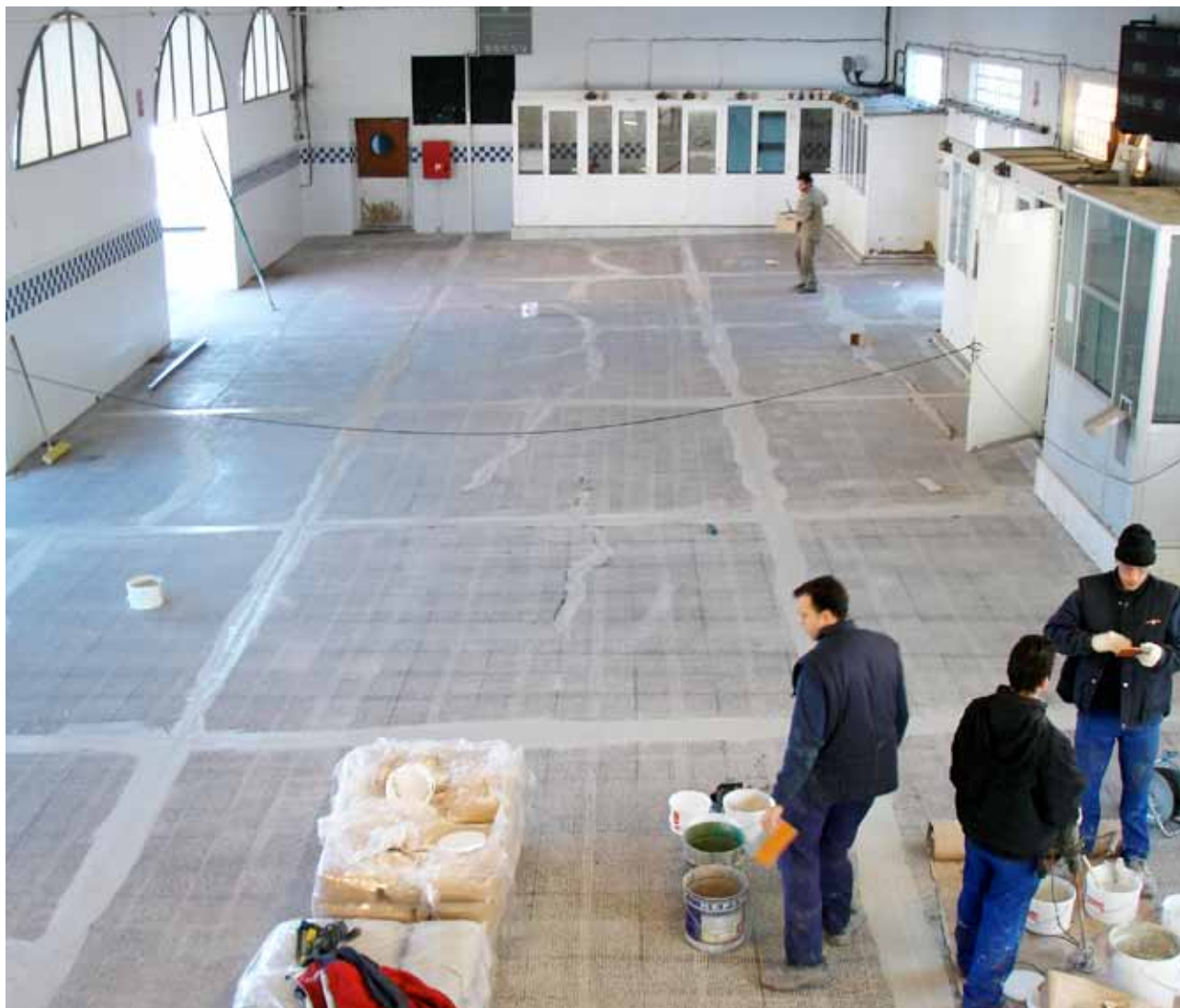
Suelo tras la preparación del soporte y tratamiento de las juntas de rotura con resina, a modo de mortero seco
