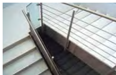
Zona común en edificio
