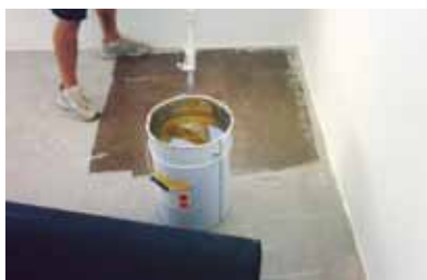
1. Aplicación de la imprimación
