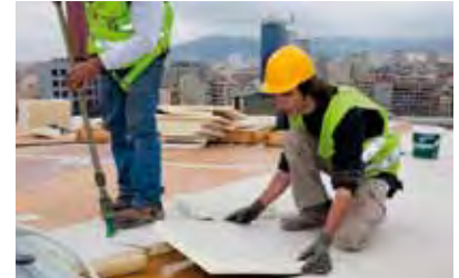
Colocación del Rayston FOAM (capa aislante)
