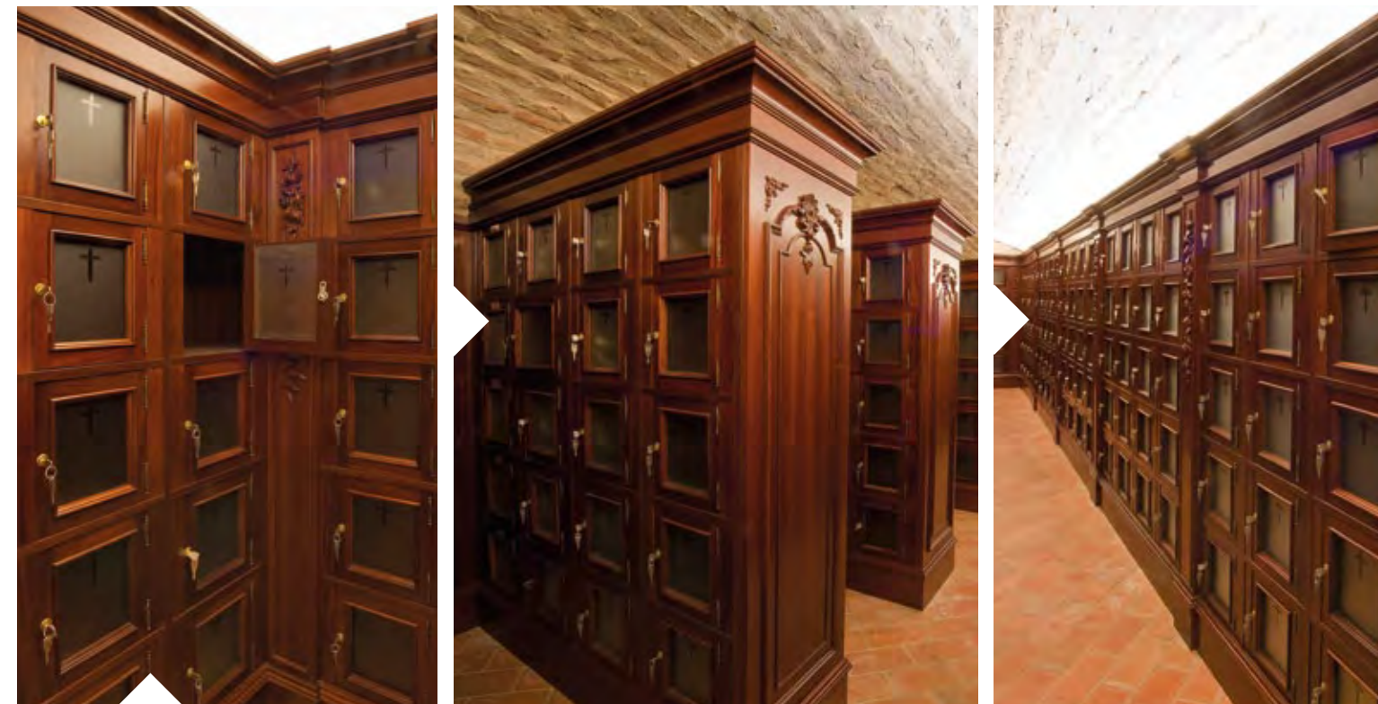
Columbario de la iglesia de La Compañía en Córdoba: se desarrolló el diseño y construcción de estas galerías de nichos de almacenaje para las urnas cinerarias, ubicadas en el sótano del templo.
