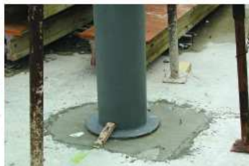
Colocación de placa base sobre mortero fluido.
