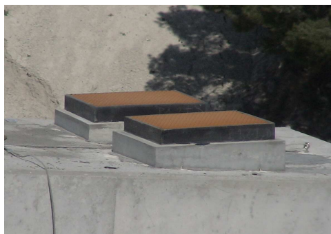
Apoyos elastoméricos zunchados antideslizantes (gofrados) en una cara
