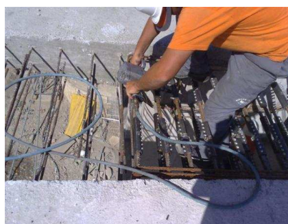
Rehabilitación puente Purchena-Pulpí Almería.
