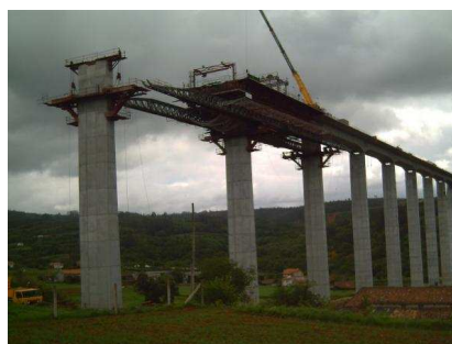
Viaducto O Eixo, Tramo AVE Santiago Compostela, Ourense
