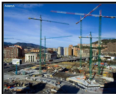
Torre Iberdrola. Bilbao
