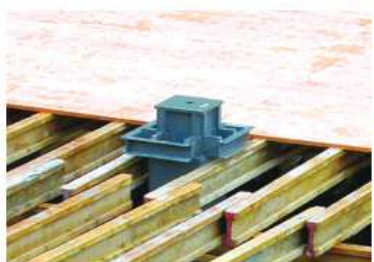
Colocación de encofrado bajo armadura de punzonamiento.
