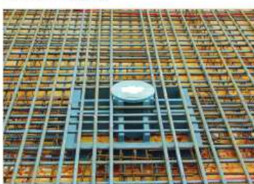
Colocación de la armadura de flexión.
