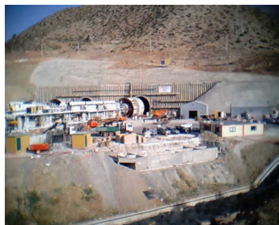
Tunel Ave. Tramo Abdalajis. Málaga
