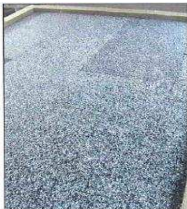
Colocación Copopren negro simplemente apoyado
