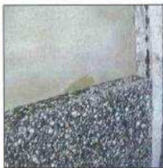
Colocación copopren negro en tabiquería con cola D5
