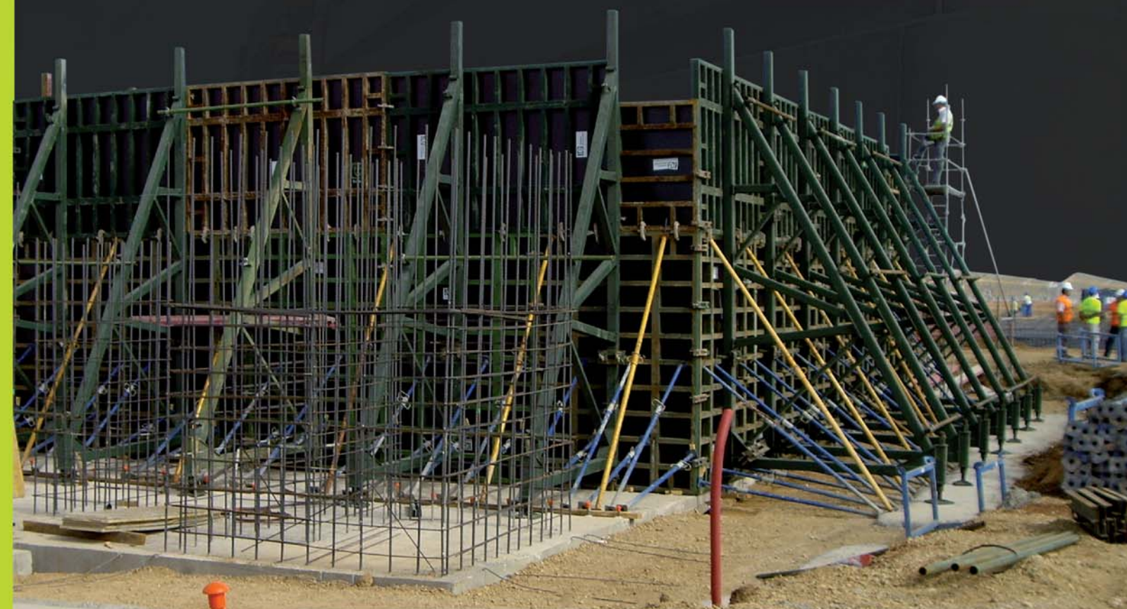
Anclaje de borde: Seguridad extra en las esquinas de muros
