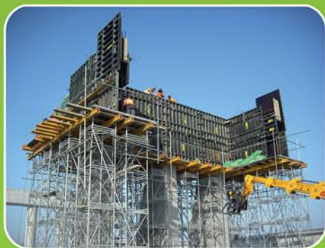
Adaptabilidad: El sistema MULTIMAX se adapta a cualquier geometría de muros rectos, incluso con base en pendiente.
