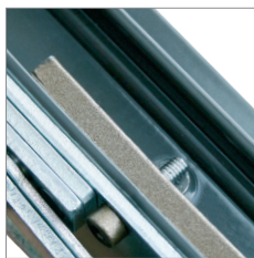
Sistema que dificulta el desmontaje del vidrio desde el exterior
